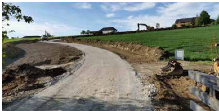
Fertigstellung des Unterbaus
