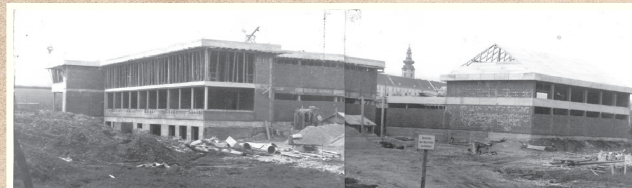
1970: Baustelle der Hauptschule
