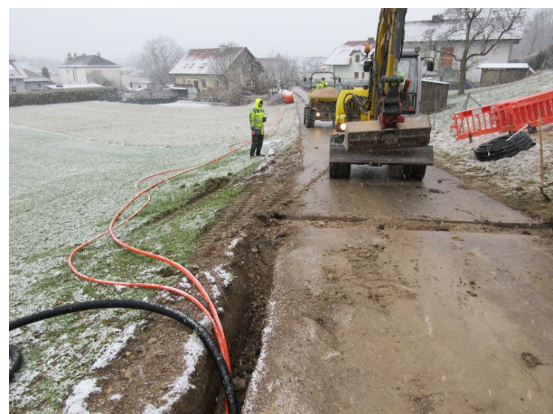
Foto: Bald werden über 100 km Glasfaserkabel im Gemeindegebiet verlegt sein
