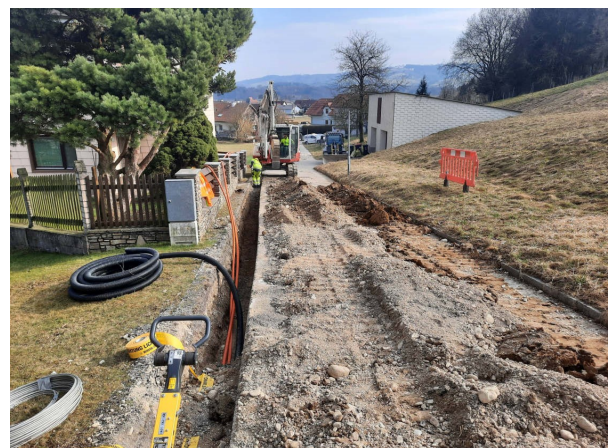
Foto: Jetzt geht's los - gebaut wird an mehreren Stellen gleichzeitig
