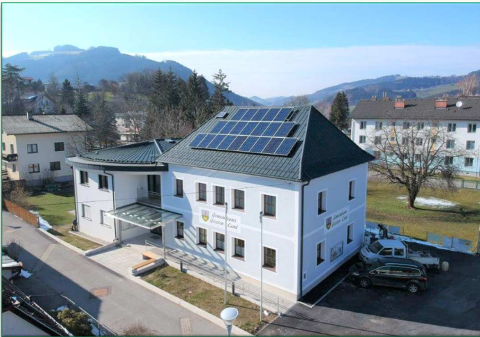
Eigenversorgung mit Photovoltaik. Gebäude mit Zukunft das neue Gemeindeamt.
