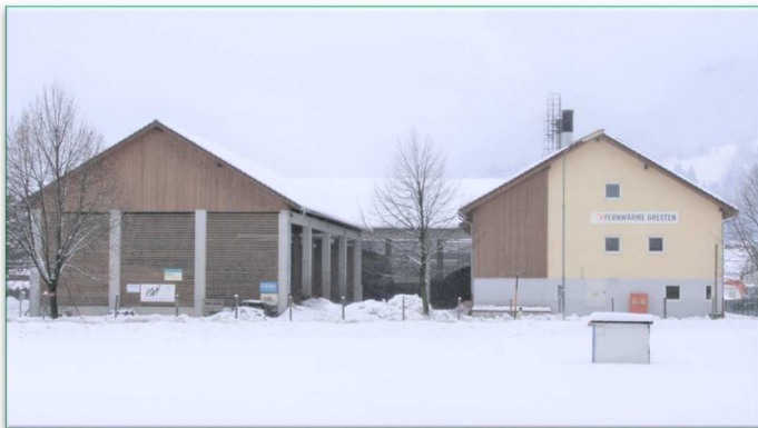
Das Heizwerk in Gresten versorgt mittlerweile mehr als 500 Haushalte mit Wärme.
