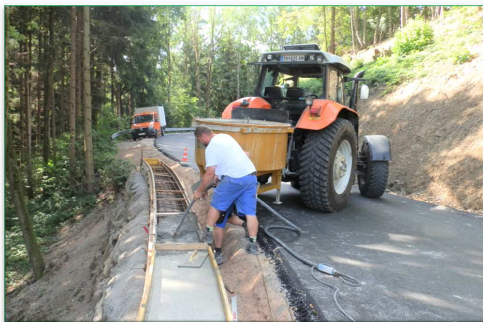
Sanierung Verbindungsstrasse Steinbachsiedlung 2019.
