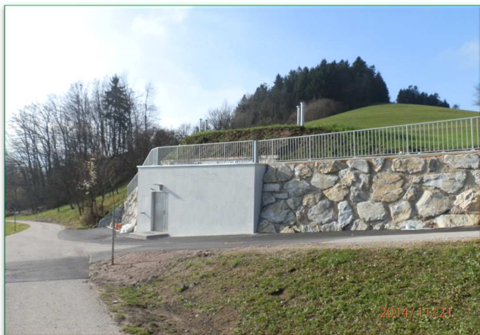
Hochbehälter WVA Unteramt.
