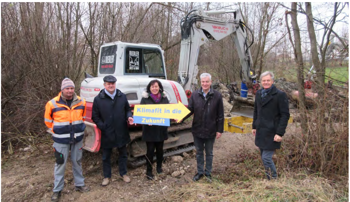
Besichtigten die letzten Grabarbeiten für die erweiterte Wasserversorgung in der Gemeinde (v.l.n.r.): Wassermeister Martin Reitbauer, Vzbgm. Mag. Walter Lettner, Bgm in Juliana Günther, LAbg. Bgm Anton Kasser und Ignaz Röster (Regionsleiter der Energie- und Umweltagentur im Mostviertel)
