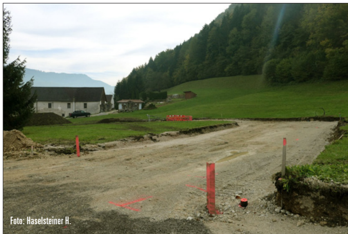
Die Fa. Kraml fertigte bereits die Rohtrasse des „Ziegelweges“!
