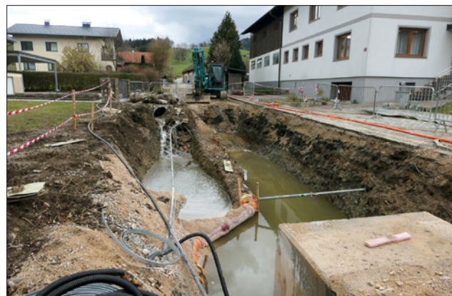
Eine Großbaustelle war die Regulierung des Hoderberggrabenbaches in der Badgasse, die heuer ebenso abgeschlossen werden konnte.
