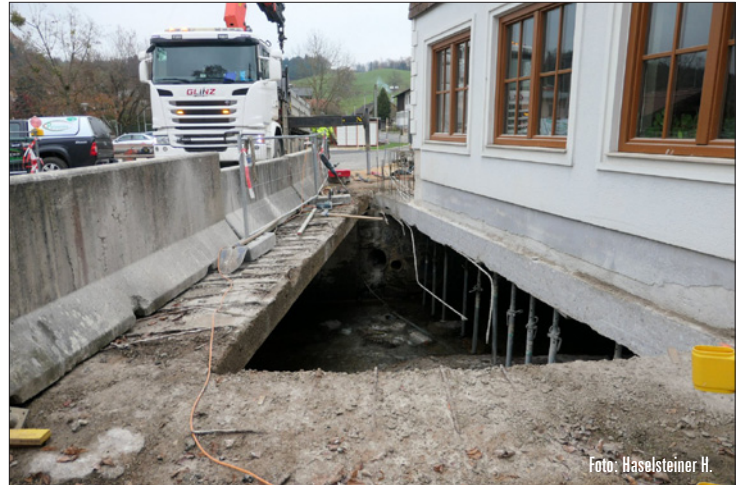
Die Badbrücke wurde geöffnet, damit die entsprechende Sanierung erfolgen kann.
