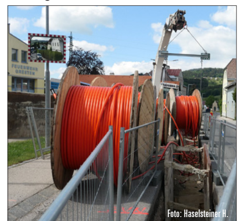
In den letzten Straßenbaustellen wurde bereits eine Leerverrohrung für die Lichtwellenleiter eingelegt.
