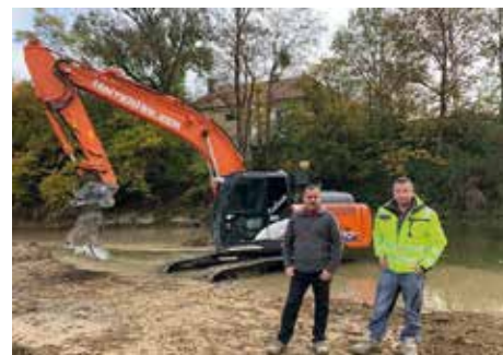
Klaus Wieser von der Firma Brandstetter und Andreas Hehenberger von der Firma Hinterholzer leisteten als Baggerfahrer eine Hauptteil der Grabarbeiten.
