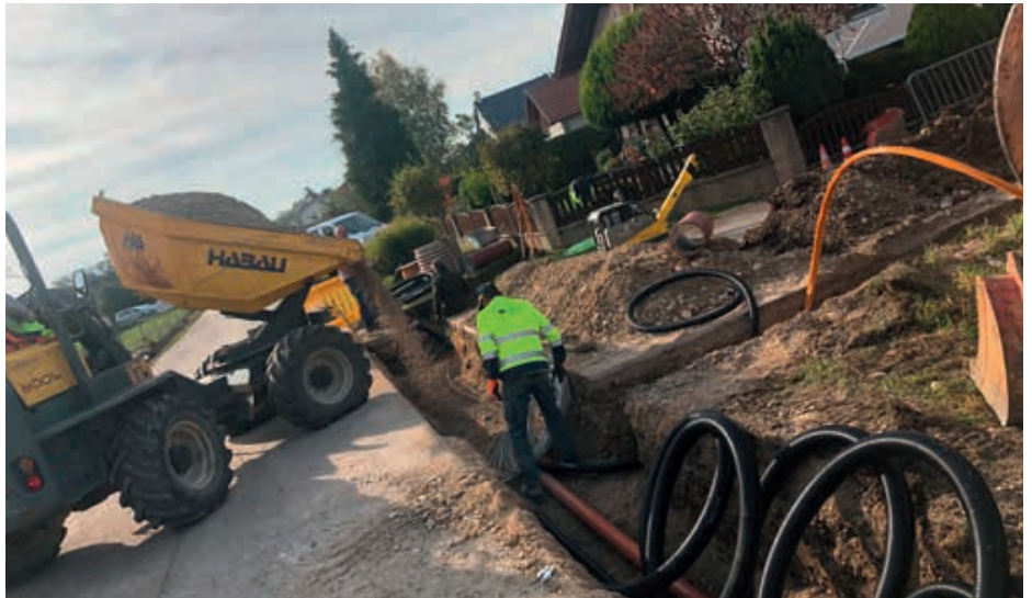
Zwischen Hermannsdorf und Balldorf wurde in den vergangenen Monaten eine Straßenbeleuchtung verlegt. Auch ein Lichtwellenleiter-Leerrohr wurde mitverlegt.
