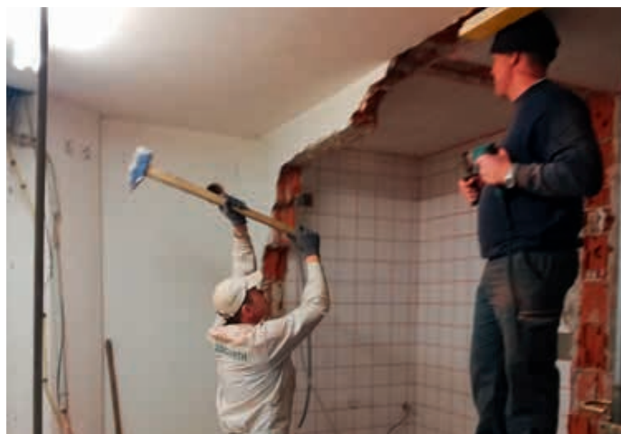
Die Fahrzeughalle und die Werkstatt wurden renoviert. Dazu wurden auch Wände abgerissen...
