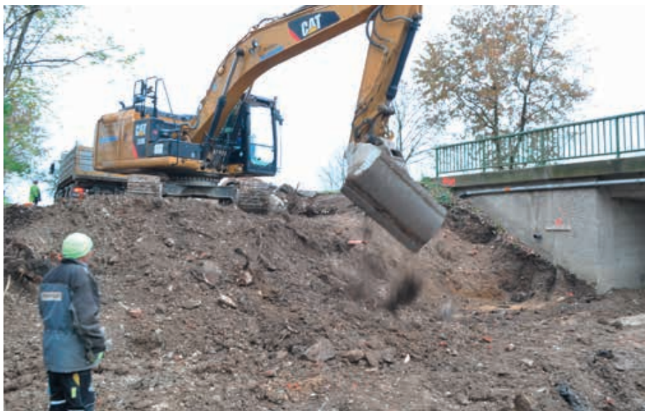
Die Arbeiten für die sichere Unterführung durch die B1 haben bereits begonnen. Zuerst werden die notwendige Brücke über den Seiseneggerbach und der dahinführende Weg errichtet.
