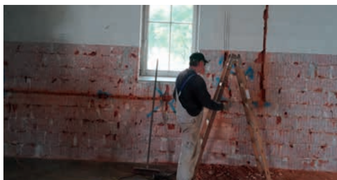
...und die Elektrik erneuert und im Mauerwerk verputzt.
