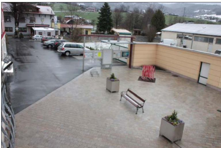
Die Bauarbeiten am Rathausplatz sind abgeschlossen
