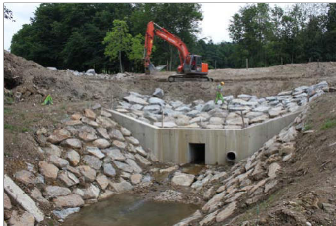
Auf der Vorderseite des Dammes das Auslaufbauwerk. Vermurungen bei Hochwässern sollten jetzt der Vergangenheit angehören.
