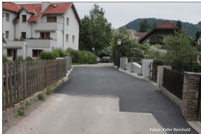
Das fertiggestellte Brückenbauwerk in der Schönauergasse.
