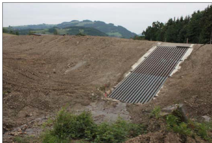
Ein gewaltiges Bauwerk - die errichtete Rechenanlage mit dem aufgeschütteten Damm des Brunnstubenbaches.
