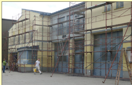
Rege Fassadensanierung beim FF-Haus in der Wieselburgerstraße
