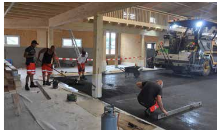
Asphaltierung der Stockbahnen
