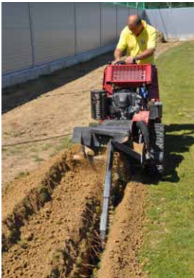
Verlegung der Bewässerungsanlage am Hauptspielfeld
