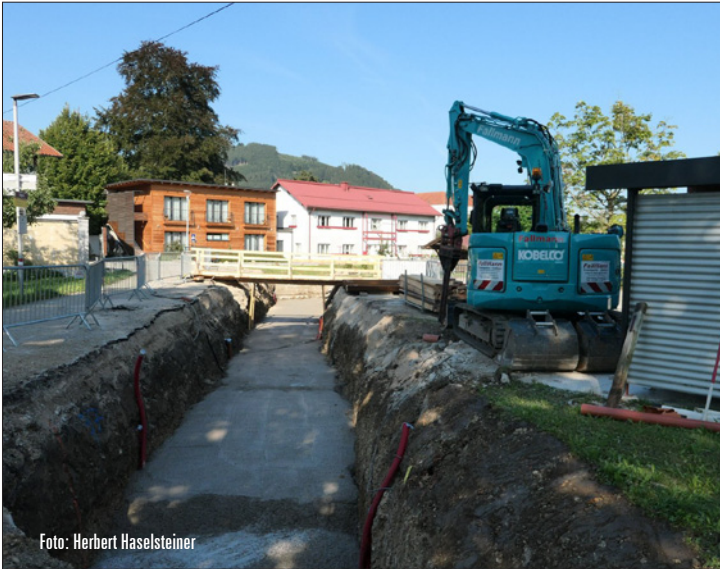
Die erste Baustelle war die Verbauung des Hoderberggrabenbaches im Bereich Gasthaus Kummer. Inzwischen ist die Straßensperre aufgehoben, und die Verbindung zur Erlaufpromenade wieder hergestellt!
