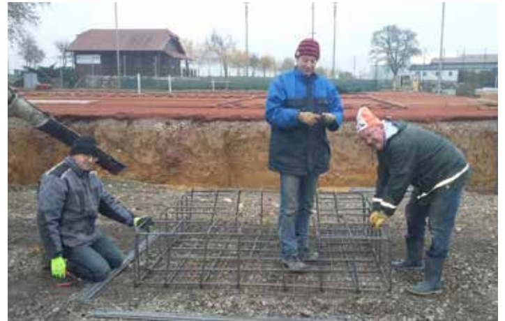
Herbert Brandstätter, Michael Tagwerker und Erwin Schörghuber beim Binden der Fundament Eisenkörbe.
