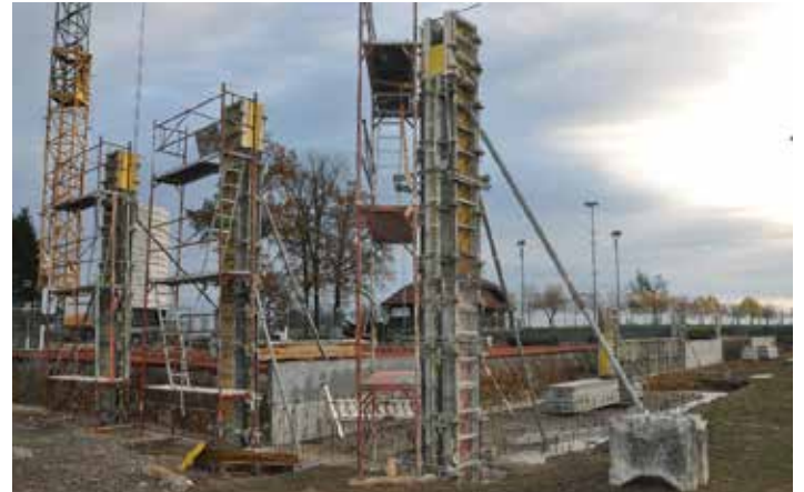
Die ersten Säulen der Stockschützenhalle.
