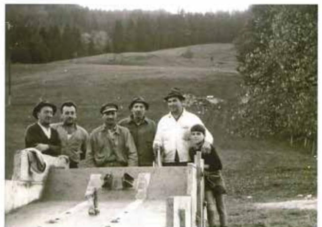
Agidius Dorfmayr, Engelbert Krenn, Otto Bukovsek, Hermann Ortner und Hubert Schagerl mit Sohn Helmut vor Beginn des Baus der Liftanlage
