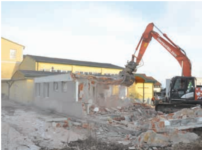
Abbrucharbeiten beim Lehrerhaus
