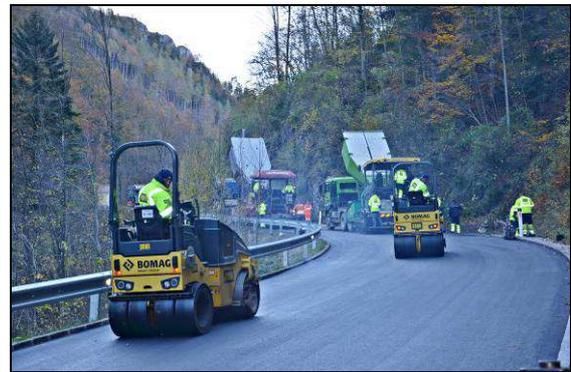
Darüber hinaus war die Straßenentwässerung bereits defekt und unzureichend, wodurch permanent Oberflächenwasser in die Straßenkonstruktion gelangte und Schäden verursachte, was umfangreiche Setzungen zur Folge hatte. Nach der Sanierung von Setzungen wurde eine neue Asphaltdecke aufgebracht. Die Fahrbahnbreite von 6,5 Meter blieb unverändert.
