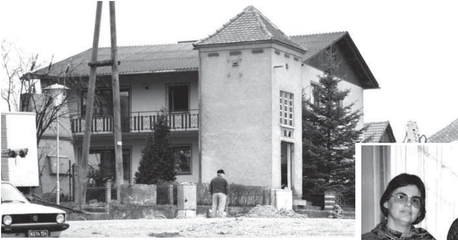
Der alte Trafo beim Haus Haag, Wassergasse, unmittelbar vor dem Abbruch. Foto vom 31. März 1993
