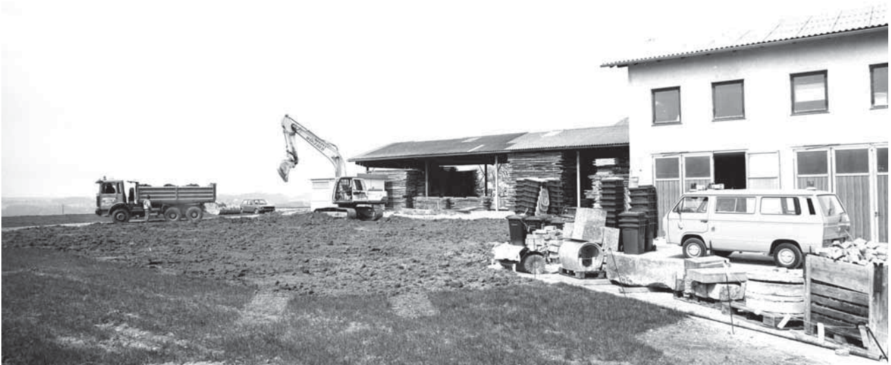
Straßenbau in der Edelsteinsiedlung am 17. April 1993, die ersten Grundstücke wurden bereits zum Ausbaggern markiert.
