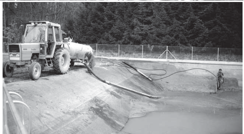
Reinigung des Klärbeckens der Abwasserbeseitigungsanlage am 31. März 1993
