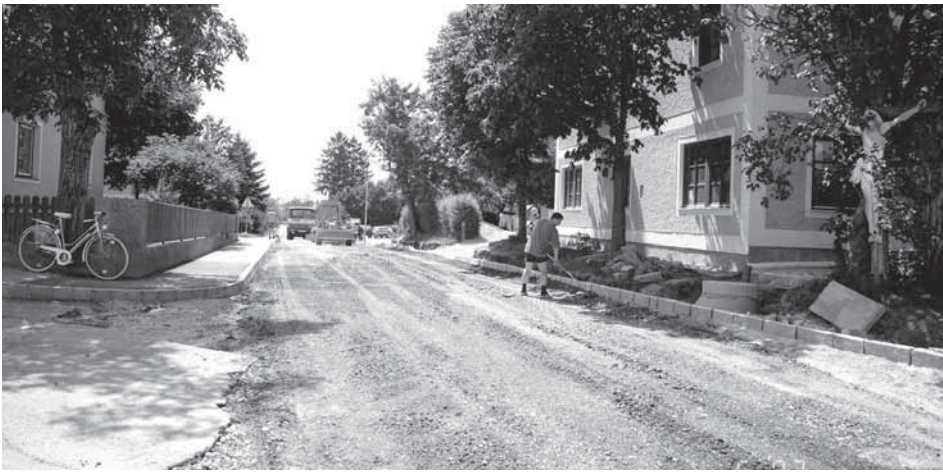
Arbeiten an der Wiederherstellung der Römerstraße nach der Verlegung aller Einbauten.
