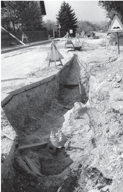
Bauarbeiten im Rahmen der Erweiterung der Tennisanlage an der Karlingstraße Ende April 1993.
