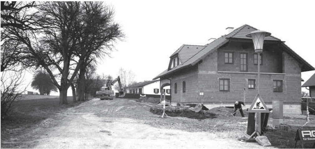
Arbeiten an den Aufschließungsstraßen in der Mühlausiedlung im Frühjahr 1993. Das Foto zeigt den Mühlaweg.
