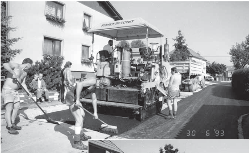
Asphaltierung der Wassergasse am 30. Juni 1993.
