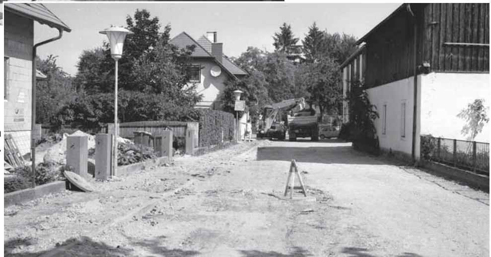
Baustelle "Hoher Rain" am 30. Juni 1993.
