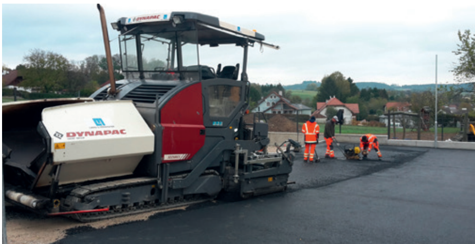
Ende Oktober wurde mit den Asphaltierungsarbeiten im Bereich der Volksschule eine der letzten Projektbestandteile umgesetzt.
