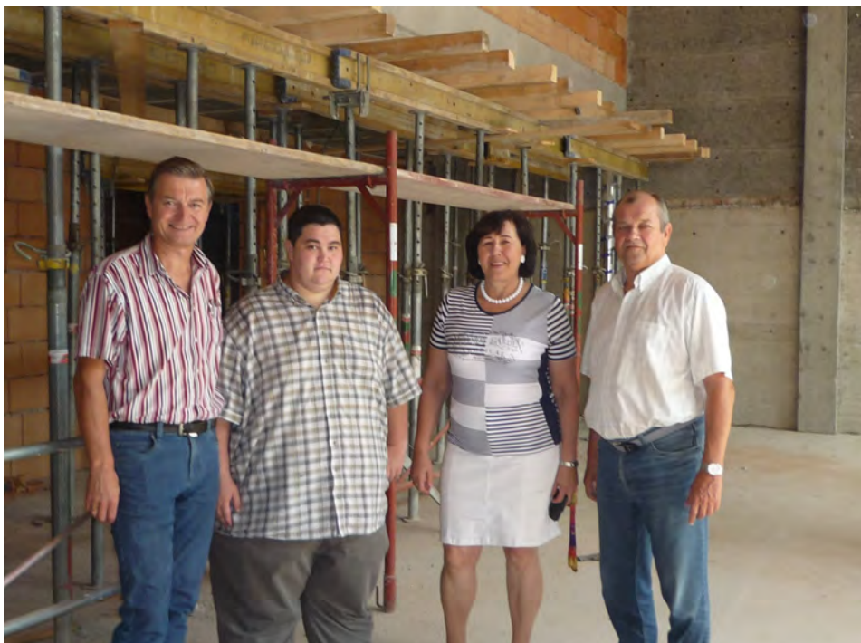
Foto: Bgm. Juliana Günther und Vzbgm. Mag. Walter Lettner (re) mit gGR Ing. Karl Wadsak (li) bei einem der vielen Lokalaugenscheine auf der Baustelle
