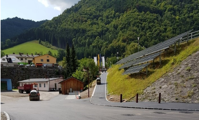
Das Saunawegerl, der Recyclingplatz sowie die bereits überhöhte Zufahrt - als erste Maßnahme zum Hochwasserschutz - wurden perfekt umgesetzt.
