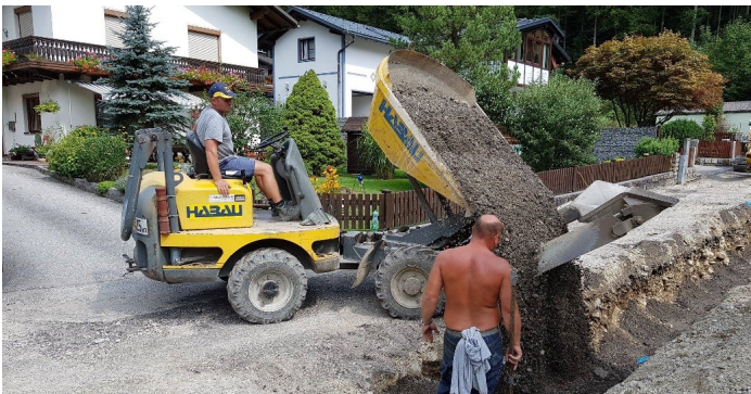
Die Fa. Habau - mit ihren Mitarbeitern Roman Raab u. Leander Ertelthalner - ist ein verlässlicher Partner an der Baustelle
