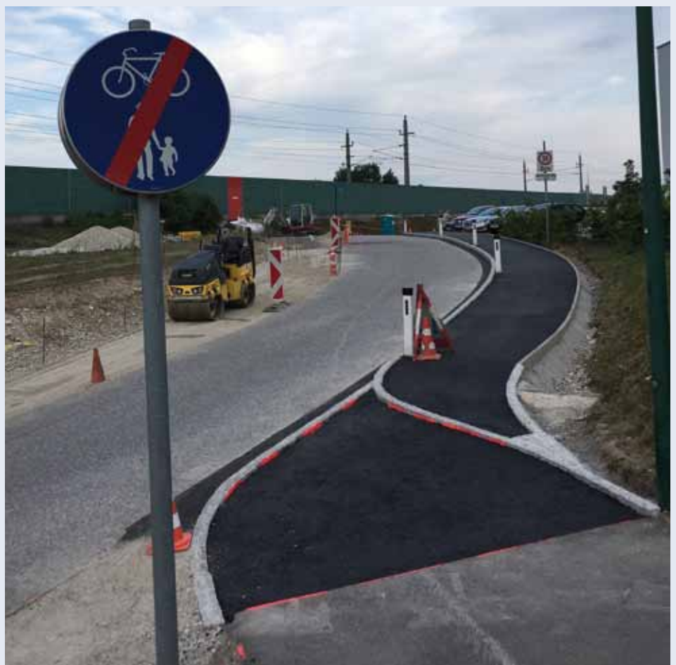
Bild: Der neue Gehsteig in der Sperlinggasse.
