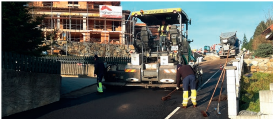
In Triesenegg wurden Teile der Trieseneggerstraße bzw. der Straße „Am Kühberg“ asphaltiert nachdem zuvor der Oberflächenwasser-Kanal erneuert wurde.
