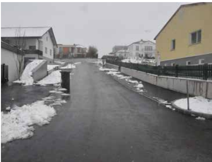
Asphaltierung der Siedlungsstraße in Kirchstetten
