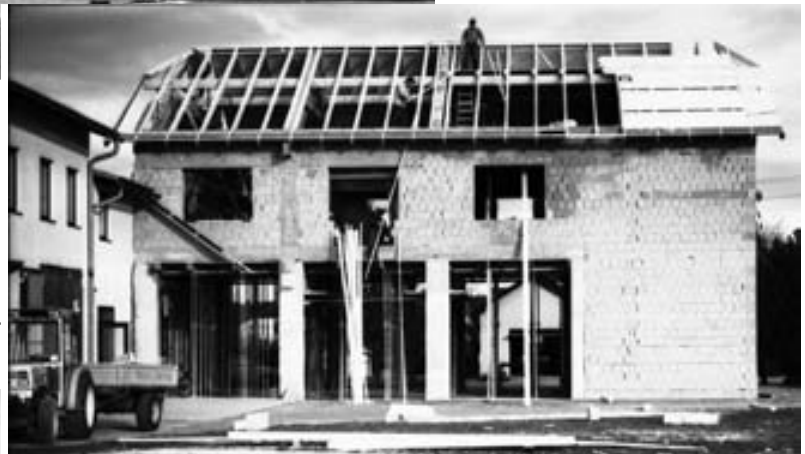
8. November 1991: Herstellen des Kaltdaches
