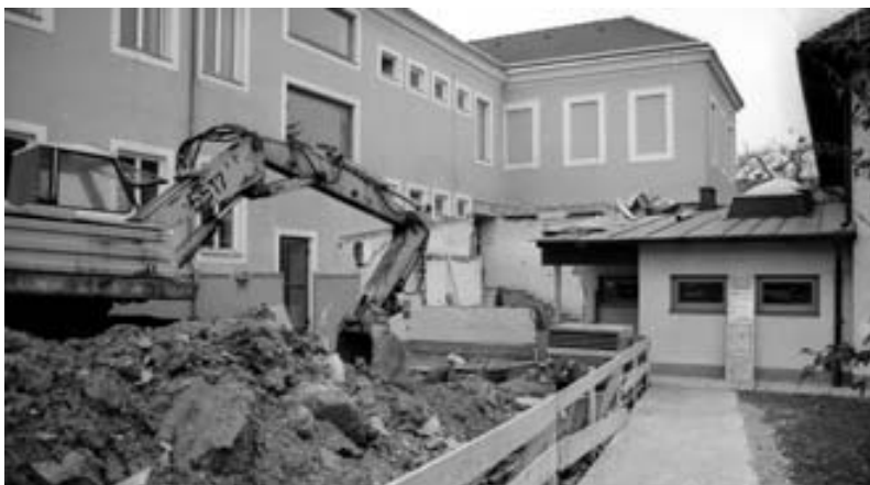
Links: Abbruch des Verbindungstraktes zum Volksschulturnsaal im November 1991. In der Bildmitte ganz hinten ist der frühere Abgang zum Turnsaal zu sehen.
