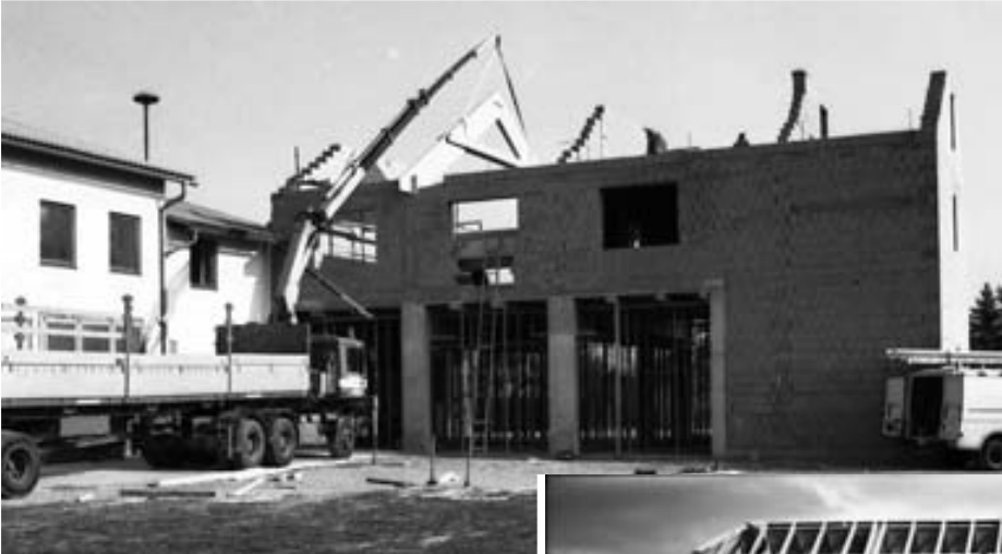
31. Oktober 1991: Versetzen eines Leimbinders für den Proberaum im Musik- heim.
