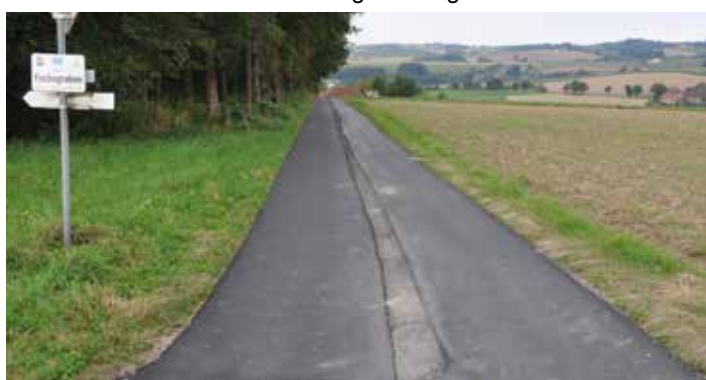
Sanierungsarbeiten beim Güterweg Fuchsgraben
