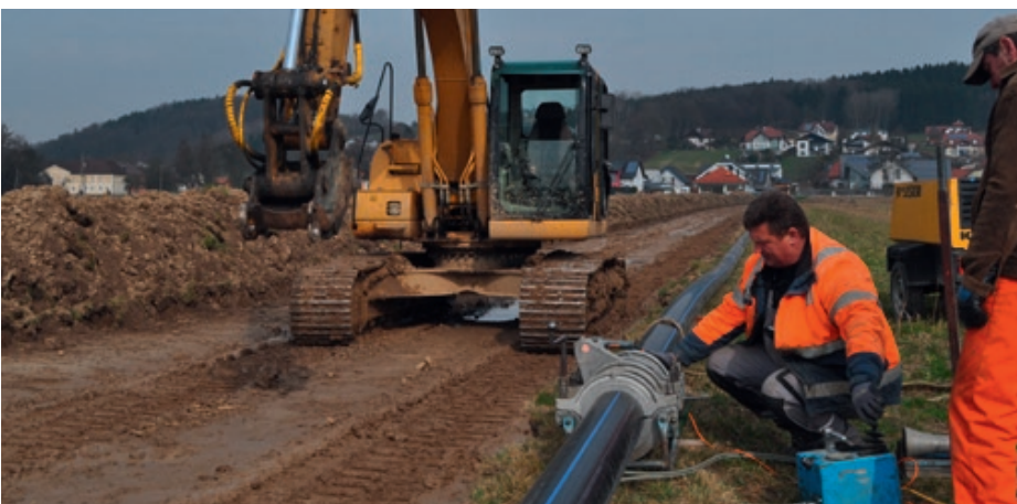
Die neue Wasserleitung reicht vom Brunnen in der Doislau bis zur Anschlussstelle bei der Feldholzstraße und transportiert zukünftig das Wasser in die Hochbehälter.
