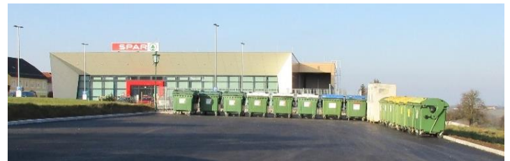
Die neue Müllsammelstelle in der Buchstraße.
