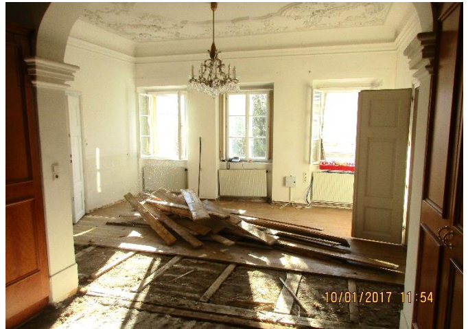
Bodenneuerlegung am Gemeindeamt (am Bild: Empfangszimmer).
