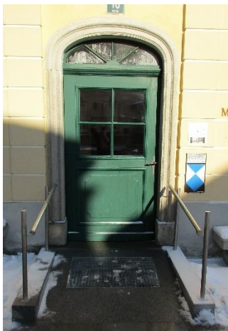
Der neue barrierefreie Eingang beim Amtshaus.
