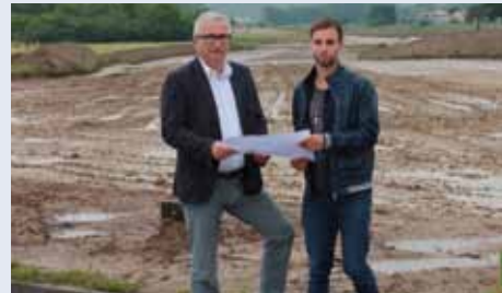
Bild: Bürgermeister Alfred Buchberger und Gf. GR Daniel Lachmayr bei der Besichtigung der Baustelle.
