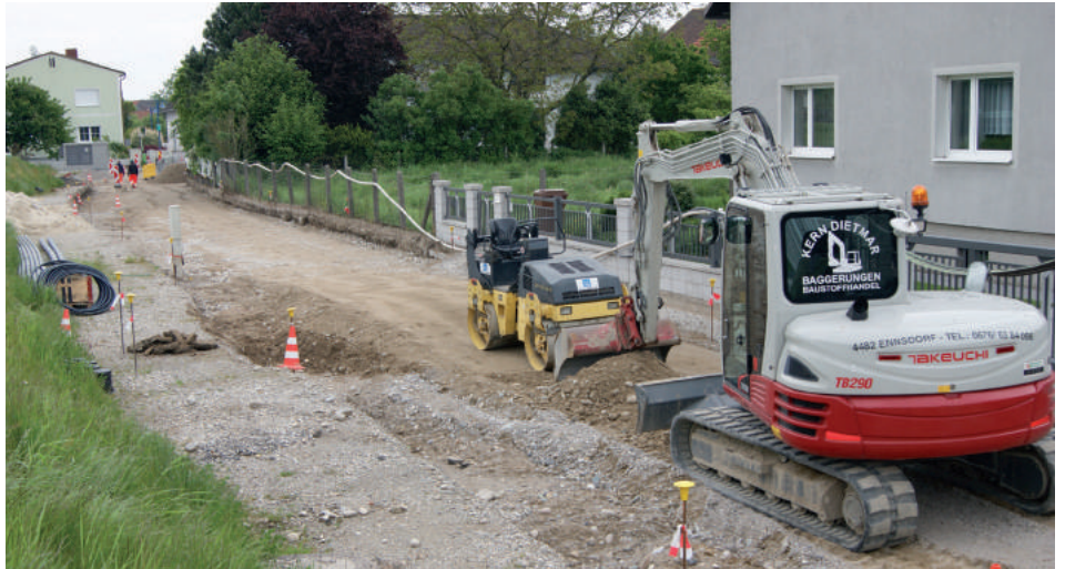
Bild: Sanierungsarbeiten im Ennsweg.
