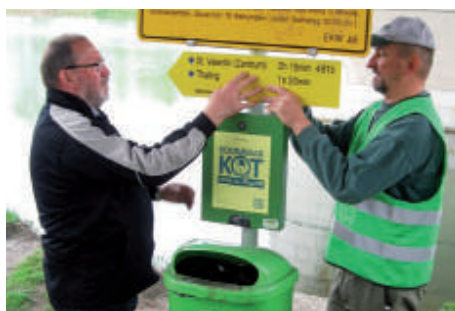
Bild: Montage der neuen Tafeln.
