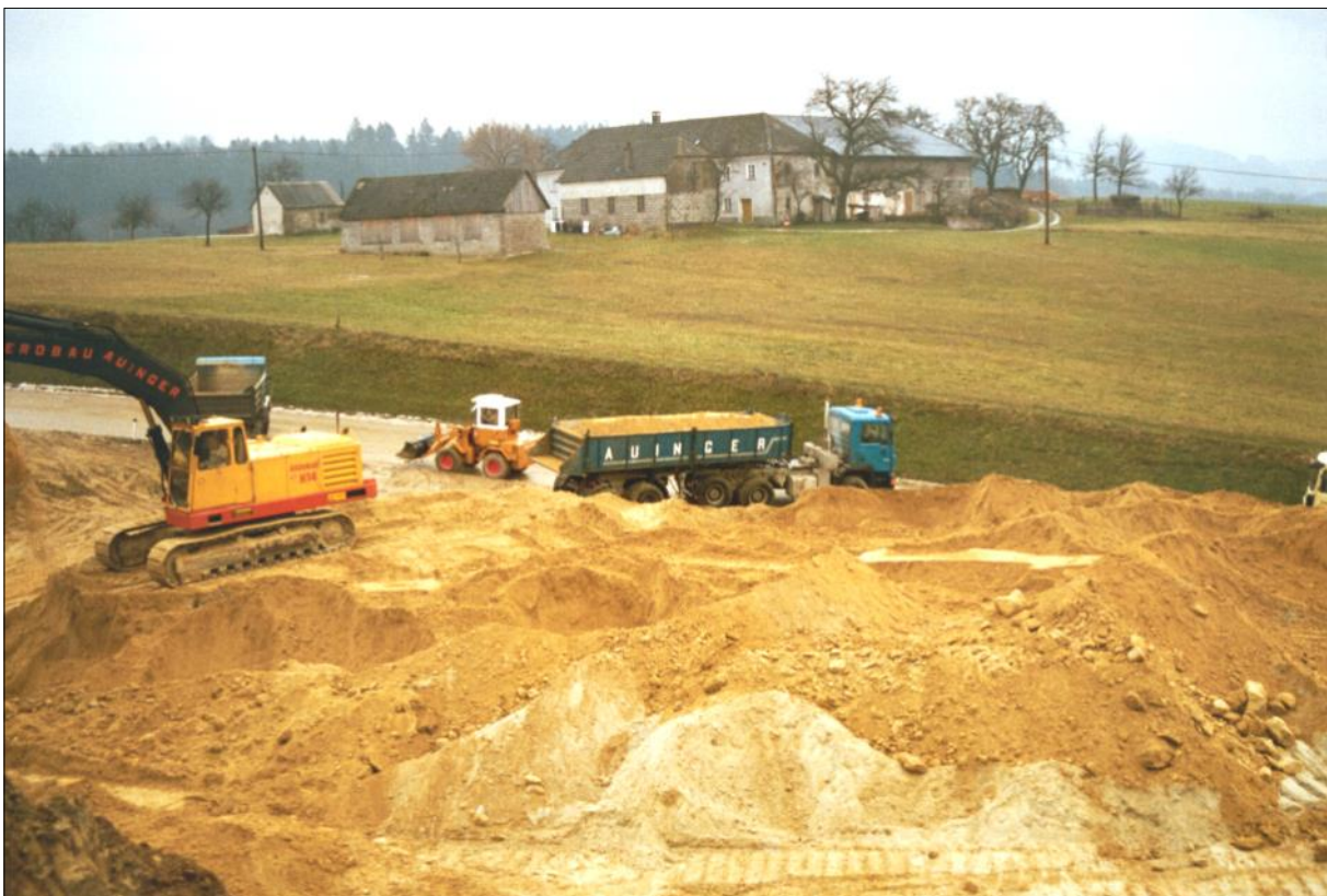
Die Firma Auinger renaturiert die Sandgrube, die zum Hause Polzmühle gehört.
