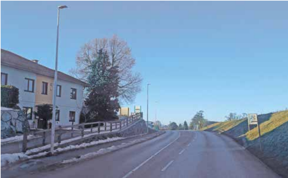
Neue Straßenbeleuchtung erhöht Sicherheit am Schulweg
