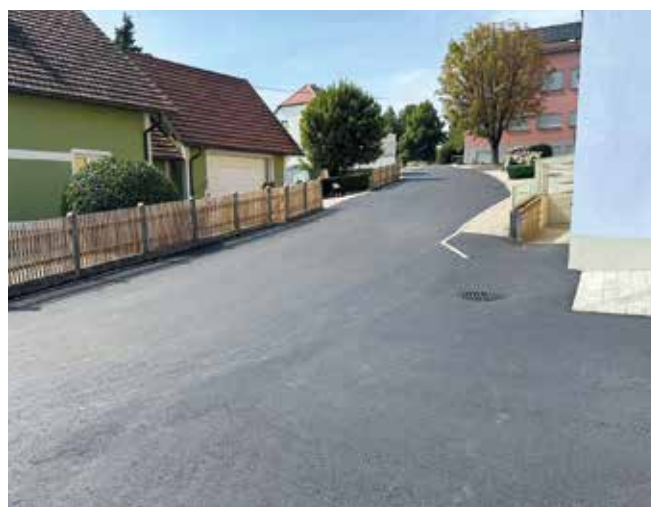
Asphaltierung der Vogelweiderstraße
