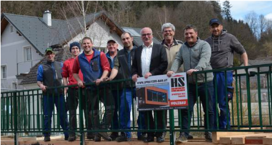
Gelungene Stegsanierung im Bereich Grestner Straße: Bgm. Gerhard Lueger, Bauhofleiter Harald Reisinger, Herbert Hochpöchler und den Mitarbeitern der Fa. Spreitzer und dem Bauhof sowie Anrainer Raimund Scheiblauber. © Marktgemeinde Ybbsitz
