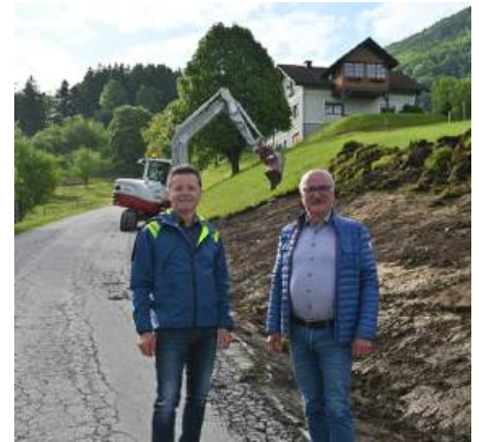
Während der Bauarbeiten muss mit kurzfristigen Wartezeiten bei der Auffahrt auf den Prochenberg gerechnet werden.
