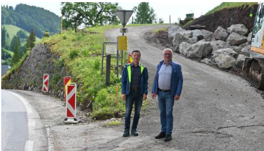
Mitte Mai wurde die Bauarbeiten für die Entschärfung der Engstelle im Bereich „Riess“ gestartet. Alle Fotos © Marktgemeinde Ybbsitz
