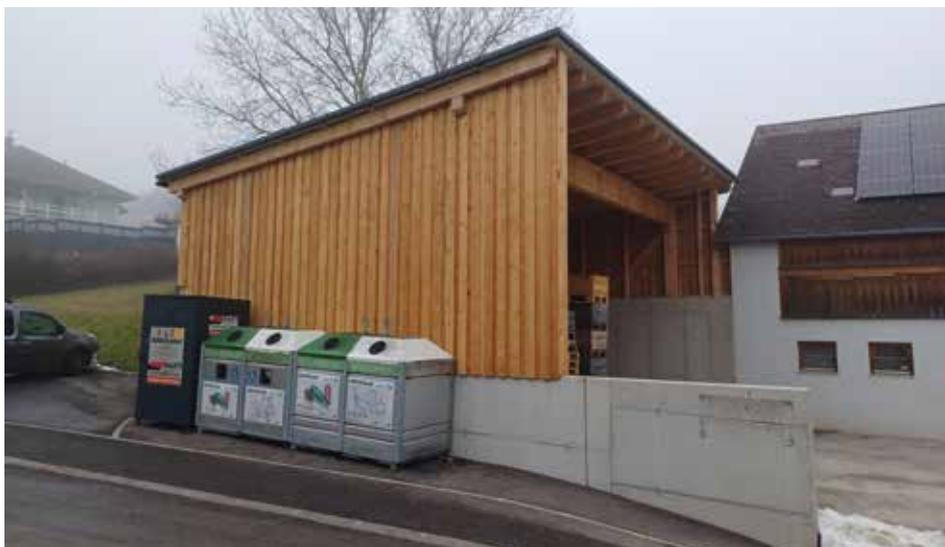
Beim Bauhof im Graben in Öhling wurde rechtzeitig vor den Schneefällen die „Rieselbox“ fertiggestellt. Da der für den Winterdienst benötigte Streusplitt unter Dach gelagert werden muss, war die Errichtung des überdachten Lagerplatzes unbedingt erforderlich. Dadurch konnte im Innenbereich des Bauhofs benötigte Lagerfläche gewonnen werden. Zudem sorgte die Lagerung und Verladung des Splitts im Innenbereich für enorme Staubentwicklung.
