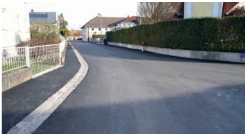
Bild: Der 1. Bauabschnitt des Ennsweges ist fertiggestellt.
