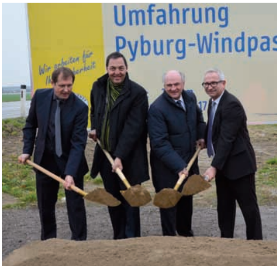
Bild v.l.n.r.: Der Spatenstich. Bürgermeister (St. Pantaleon-Erla) Mag. Rudolf Divinzenz, Straßenbaudirektor Hofrat DI Josef Decker, Landeshauptmann Dr. Erwin Pröll und Bürgermeister (Ennsdorf) Alfred Buchberger.
