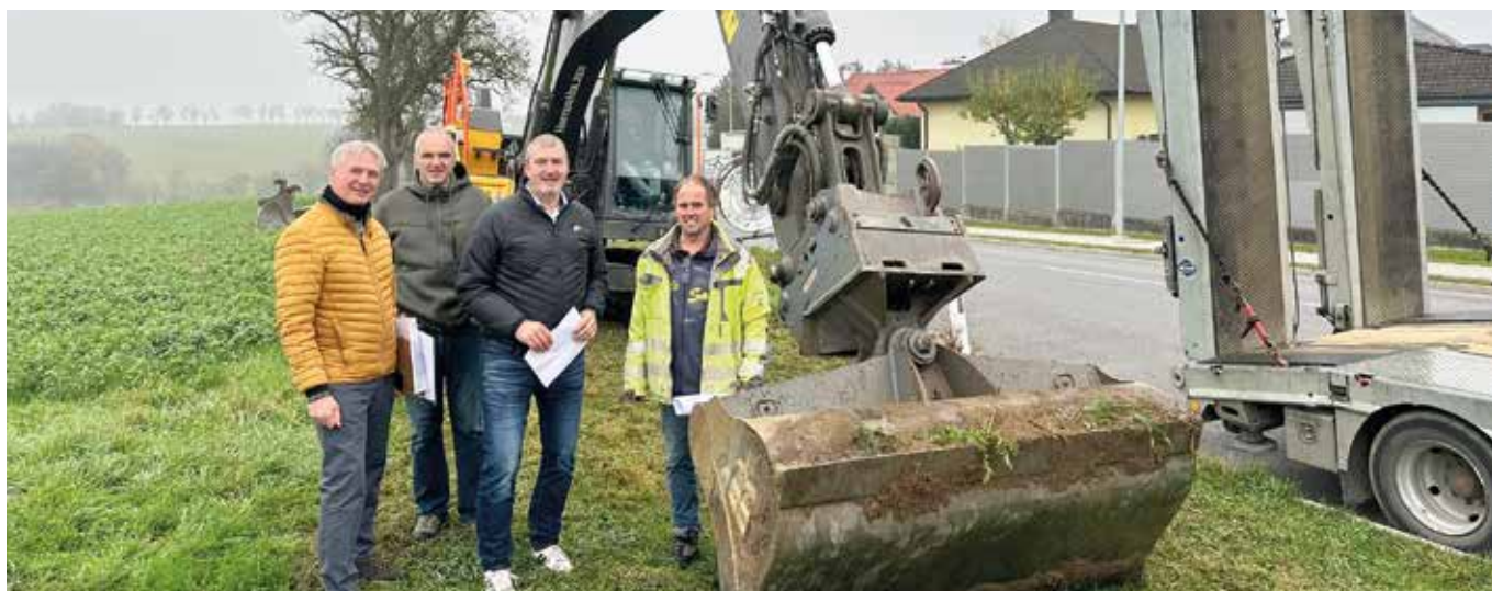
Errichtung eines Radweges vom Kruckaberg entlang der Umfahrungsstraße bis zur großen Unterführung
