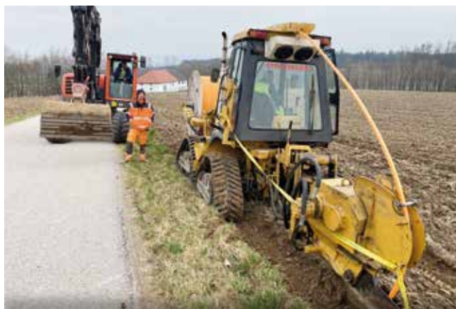
LWL-Leerverrohrung (Glasfaserausbau)
