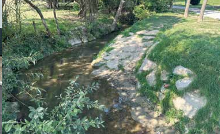
Errichtung Einstieg Zierbach
