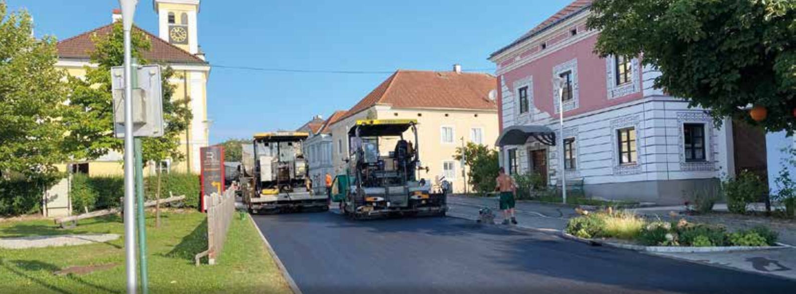
Kanal- und Straßensanierung Mittlerer Markt bis zum Oberen Markt (Billa Kreisverkehr)
