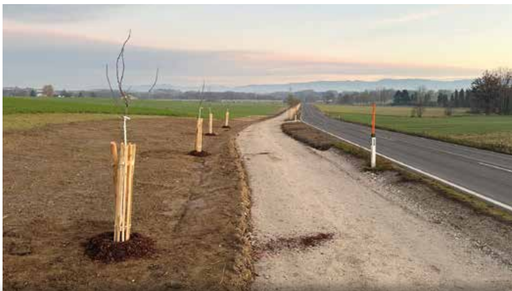
Errichtung eines Radweges vom Kruckaberg bis zur großen Unterführung
