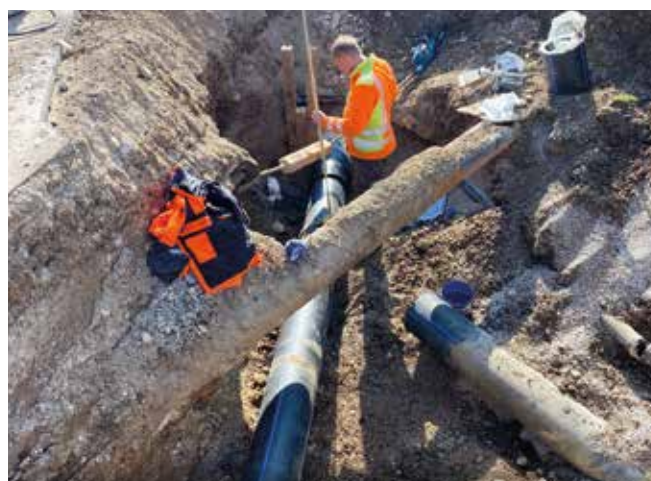
Errichtung Schmutzwasserkanal Göstling
