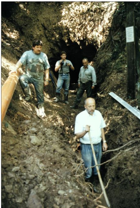
Rohrverlegung v.li.: Hans Freudenberger, Gerald Freudenberger, Anton Brandstetter und Leopold Frank
