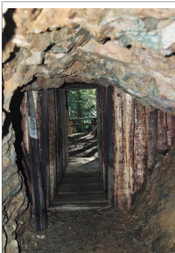
Vorbau aus Schwellen zimmern
