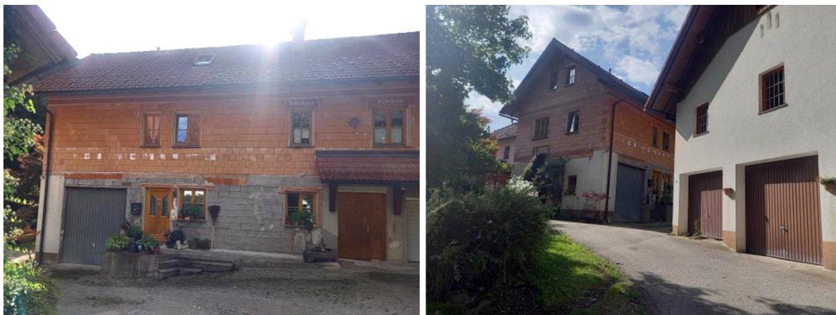
Abbildung 40: Ansicht des Objektes auf Grundstück 1930/1.
