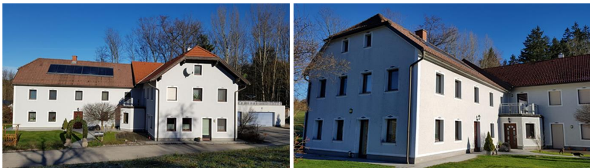
Abbildung 55: Ansicht des Objektes auf Grundstück 1033.
