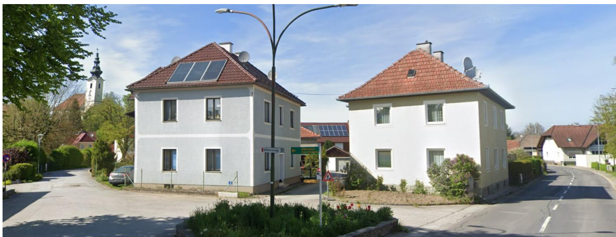
Abbildung 31: Ansicht auf den südlichen Bereich der Umwidmung (Kreuzung Bachviertelstr./Bahnhofstr.) in Blickrichtung Norden (Quelle: Google Street View).
