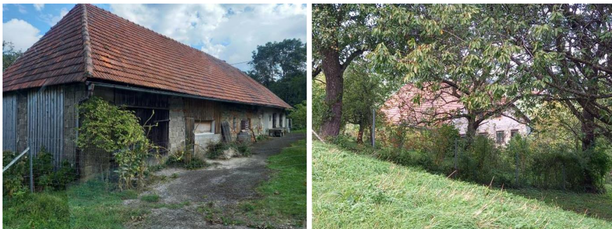
Abbildung 44: Ansicht des Objektes auf Grundstück 1612.
