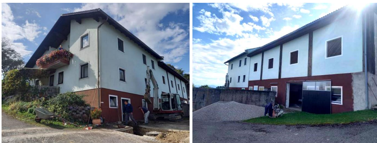
Abbildung 37: Ansicht des Objektes auf Grundstück 759/2 (Ansicht Richtung Südwesten links, Ansicht Richtung Südosten rechts).
