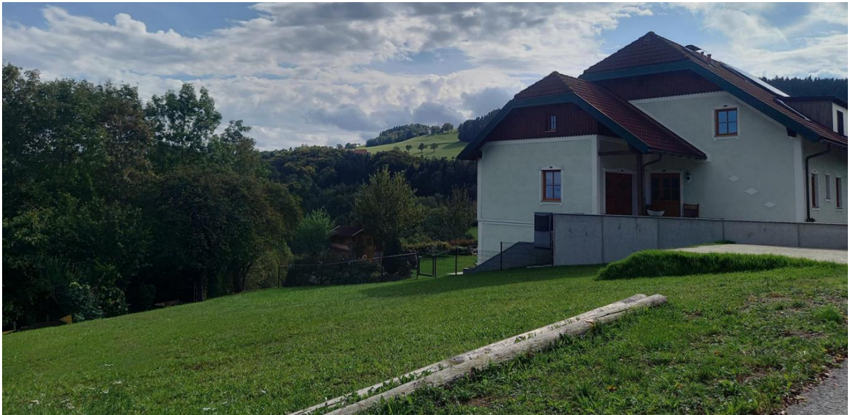
Abbildung 22: Ansicht auf den Erweiterungsbereich BW im Anschluss an das bebaute Siedlungsgebiet, Blickrichtung Südosten.
