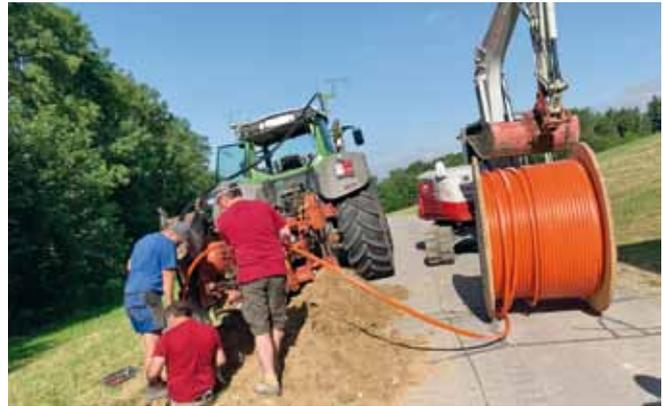
Foto: Verlegung der Glasfaser-Leerrohre.
