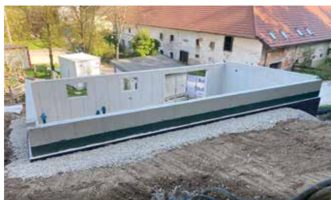
Neubau Wasser-Übergabestation in Göstling
