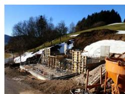
Mit den Bauarbeiten wurde bereits letzten Herbst begonnen. Die WVA Unteramt sieht einen Zweikammer-Wasserhochbehälter mit insgesamt 120m<sup>3</sup>
