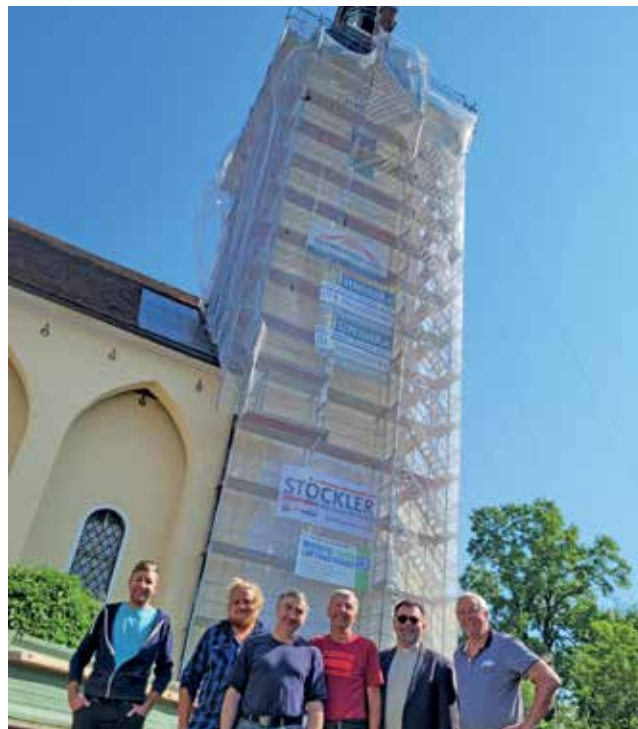
Das Pfarr-Team dankt der Bevölkerung für die Unterstützung bei der Turmsanierung.
