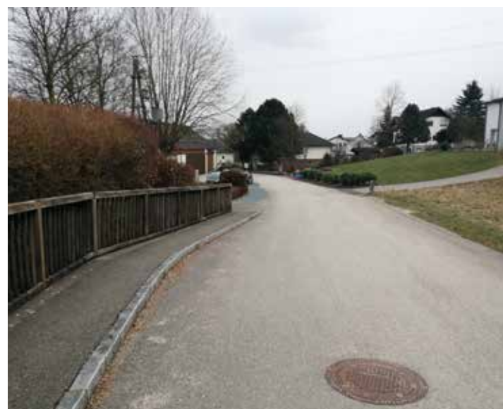
Im Graben in Öhling wird das Gerinne verrohrt. In weiterer Folge sollen hier zusätzliche Parkplätze beim Bauhof geschaffen werden.
