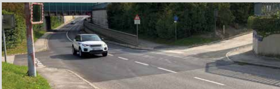
Die derzeitige Anbindung Margeritenstraße/Westbahnstraße muss sicherer gestaltet werden.
