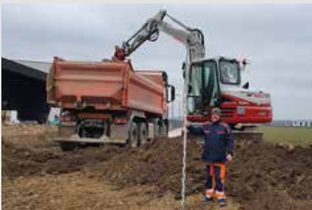
Andreas Lang war als Mitarbeiter auf vielen von der Gemeinde beauftragten Baustellen tätig.
