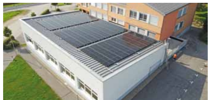
Foto: 58,48 kWp-Photovoltaikanlage auf dem Dach der Sporthalle der Mittelschule Ardagger.
