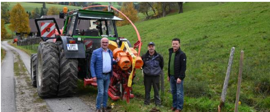
Bgm. Gerhard Lueger und Vizebgm. Georg Stockner besichtigten die Baustelle im Urlgraben, wo die Firmen Erdbau Kainrath und EHF Maulwurftechnik bereits mit den Arbeiten begonnen haben. © Marktgemeinde Ybbsitz
