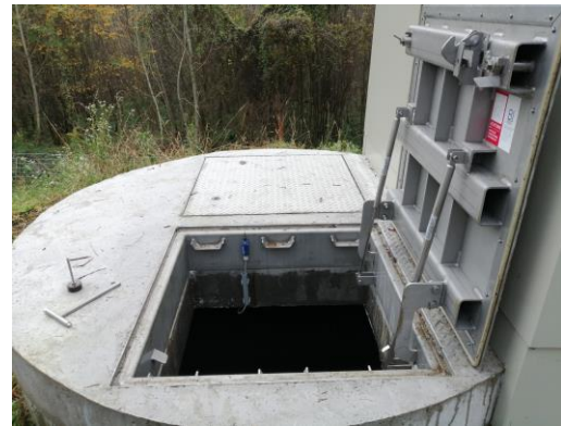
Abb. 2: Einstiegsöffnung Bohrbrunnen „Au“
