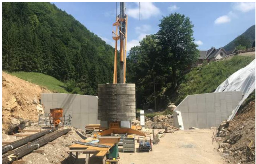
Baustelle der Geschiebesperre im Bereich Einödhammer © Marktgemeinde Ybbsitz
