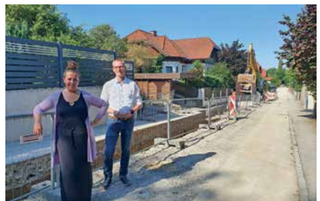
Ortsvorsteherin Julia Krifter und Bürgermeister Johannes Heuras machten sich ein Bild vom Baufortschritt in der Teichstraße.
